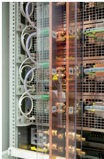
DC-Anschluß / DC bus terminal
